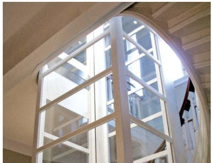
Der kompakte Schacht mit selbsttragender Konstruktion kann in einem Treppenauge ohne größere bauliche Veränderungen installiert werden.
