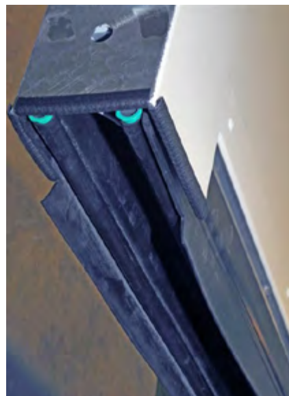
Abb. 8 Hauptschließkante am Tor mit zwei Schaltleisten
