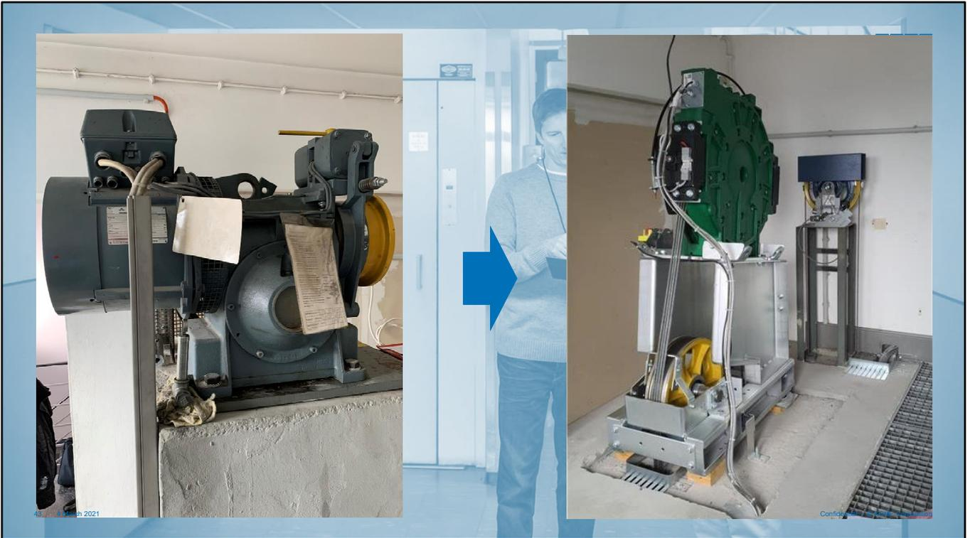
Ein weiteres Beispiel „vorher-nachher“, bei dem ein ineffizienter Getriebeantrieb durch einen hocheffizienten, leisen und getriebelosen Antrieb ersetzt wurde (zusammen mit einer neuen Steuerung – selten lässt sich ein Antrieb unter Erhalt einer alten Steuerung einfach erneuern). Hierbei musste ein bestehender Betonsockel entfernt werden.
