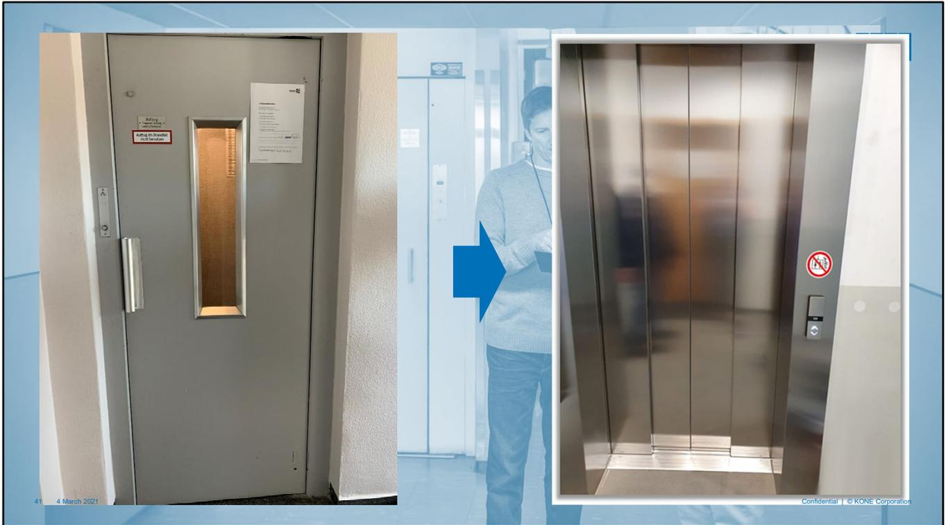
Abschließend möchten wir auf eines unserer vielen Modernisierungsprojekte eingehen. Aus einem verschlissenen Aufzug fernab des neuesten Stands der Technik mit manueller Drehtür wird ein komfortabler, gesetzlich sicherer Aufzug mit Automatiktüren. Ein wichtiger Baustein für ein barrierefreies Gebäude.
