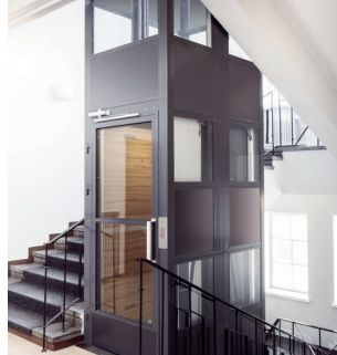
Stahlgerüst teilweise verglast geschlossene Flächen reihenweise wählbar
